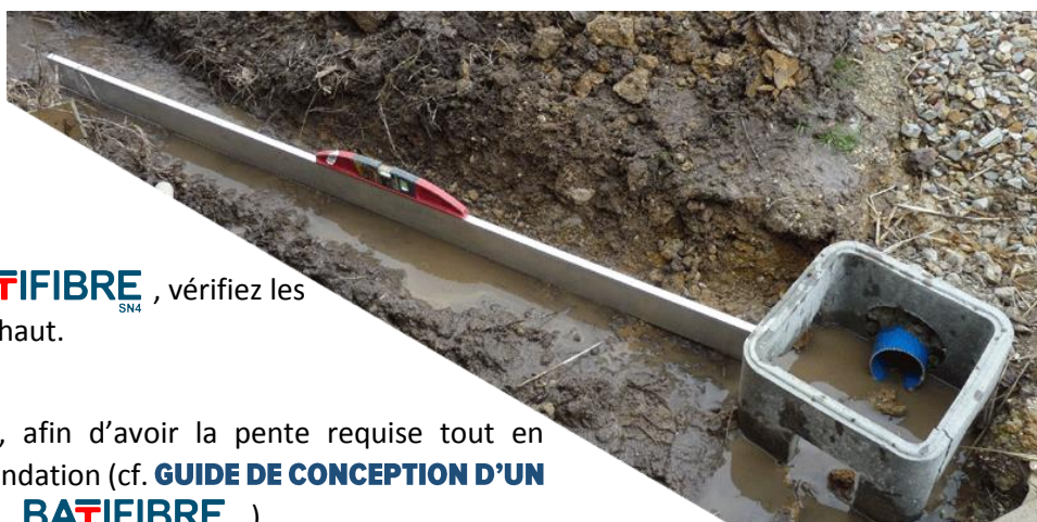
FIGURE N°13 : VÉRIFICATION DES PENTES AVANT LA MISE EN ŒUVRE DU DRAIN BATIFIBRE À DISTANCE DES FONDATIONS SN4
