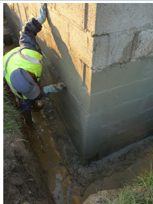
FIGURE N°11 : MISE EN ŒUVRE D'UN PRODUIT D'ETANCHEIFICATION
