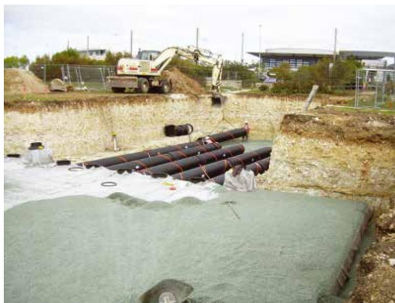
Vue d'ensemble de l'ouvrage de Gestion Intégrée des Eaux Pluviales : SediPipe pour traitement des pollutions en amont et bassin d'infiltration Rigofill connecté au réseau
