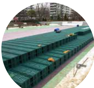
Rigofill® inspect ☞ Petit Lancy (Suisse)
