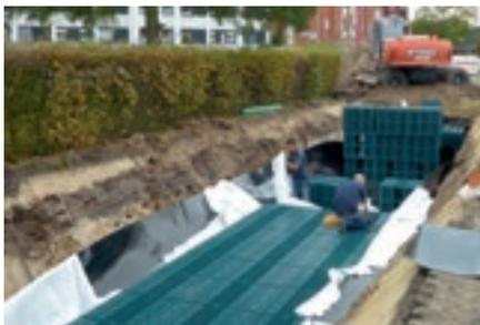
Les systèmes Rigofill inspect utilisés pour la rétention des eaux pluviales peuvent être recouverts d'une membrane étanche en matière synthétique. En plus de cette notice de montage, il faut également respecter les indications du fabricant de la membrane étanche en matière synthétique (KDB) pour son installation.
