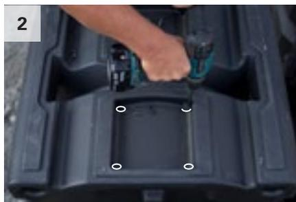
Percer un trou dans chaque angle de la surface reculée, Ø d'au moins 12 mm (le diamètre de perçage doit être supérieur à la lame de scie utilisée).
