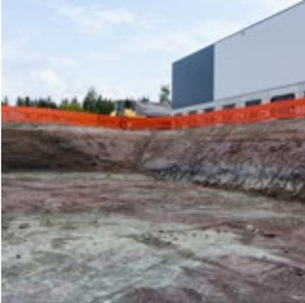
La réalisation de la fouille doit être en conformité avec les spécifications de planification. Durant les travaux d'excavation, les parois de la fouille doivent être nivelées ou endiguées afin de ne pas exposer les ouvriers à d'éventuels glissements de terrain. Par ailleurs, les consignes nationales doivent être respectées. Prendre les mesures nécessaires afin que l'eau ne s'infilte pas dans la fouille durant la durée des travaux.
