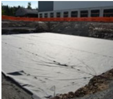
L'ensemble de la SAUL doit être enveloppé d'un tissu géotextile RigoFlor. Avant la pose des blocs, le géotextile doit être étendu sur toute la surface plane. Le géotextile doit déborder suffisamment sur les côtés afin de pouvoir ensuite envelopper l'ensemble de l'ouvrage.
