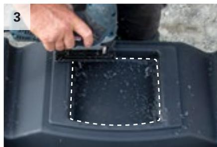
Les côtés de l'ouverture du tunnel doivent être découpés avec un outil coupant approprié.
