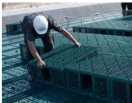
Les blocs Rigofill inspect doivent être posés sur la plate-forme suivant le plan. Ils doivent être placés en rang de manière à constituer un tunnel. En cas de gel, l'installation requiert une plus grande attention (sensibilité aux chocs, cf. remarques du chapitre Transport et stockage).
