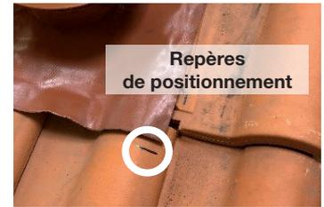
Installer la jupe d'étanchéité en la superposant sur les tuiles en veillant à recouvrir 3 cm minimum en bas et à passer la sécurité du bord de la tuile.
