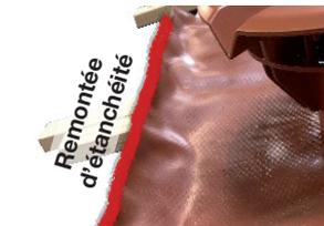
Créer une remontée suivant le sens de recouvrement de la tuile avec la jupe afin d'assurer une bonne **remontée d'étanchéité**.
