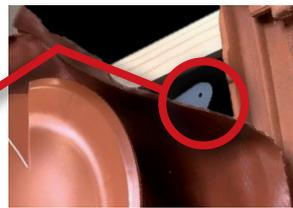
Relever la jupe pour dégager les trous de fixation de la platine. Si besoin installer un tasseau supplémentaire au niveau **des trous** de cette platine.
