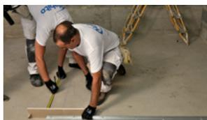
**A** À l'implantation, conserver un espace pour le parement intérieur dans l'angle de la cloison.
