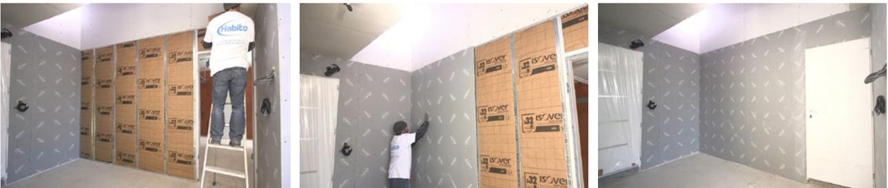
Finir l'ouvrage de manière traditionnelle en débutant par le parement intérieur dans l'angle le cas échéant. Utiliser une plaque hydrofuge de type Placomarine® côté local non chauffé.
