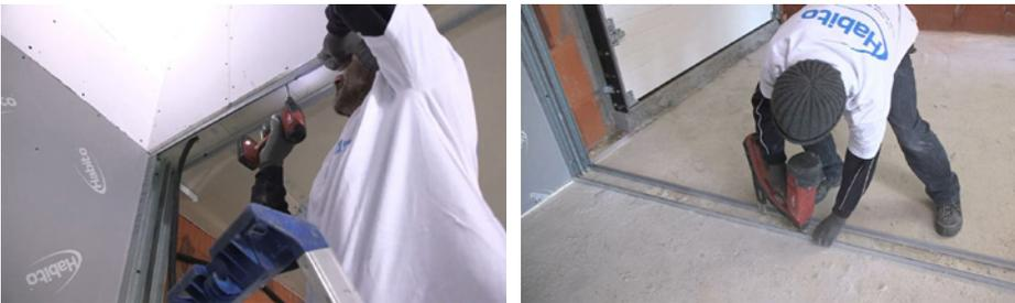
Matérialiser l'implantation de la cloison Up Stil® au sol, au plafond et sur les murs périphériques. Fixer les cornières Stil® CR2 au départ et à la fin de la cloison, au sol et au plafond.
