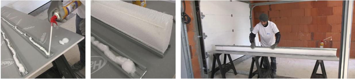
Encoller les fourrures Up Stil® 269 à l'aide d'une mousse PU <sup>(1)</sup> et clipser les blocs de PSE Up Stil®. L'assemblage des montants au PSE est définitif après 24h de temps de séchage, cependant il est possible de mettre en œuvre la cloison pendant ce laps de temps.
