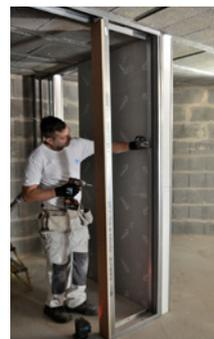
**C** À l'intérieur de la cloison, côté rentrant de l'angle, une plaque est placée à fleur du montant Up Stil® extérieur. Des cornières Stil® CR2 sont fixées le long des montants Up Stil® à travers la plaque de plâtre. L'épaisseur entre les cornières est égale à la largeur du montant Up Stil® assemblé.
