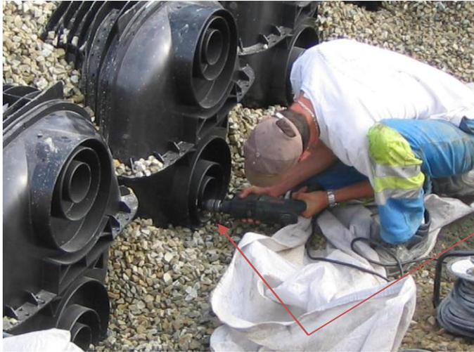
**Découpe de l'opercule avec scie cloche à PVC
