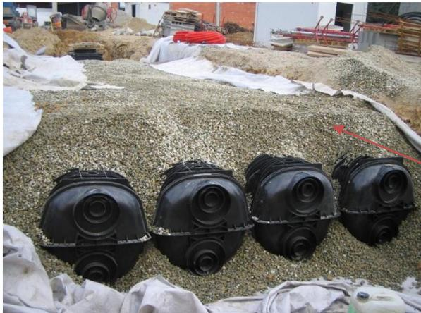
**Recouvrement de 30 cm au dessus des Twin**
