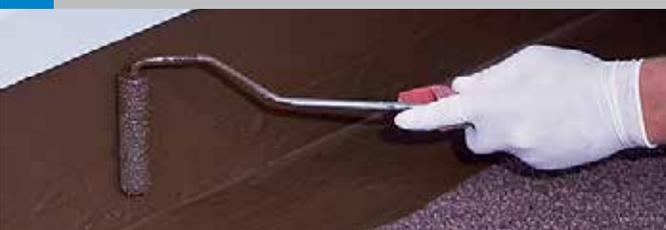
Application au rouleau d'une 2<sup>ème</sup> couche d'**Alsan® Flashing** en recouvrement de la 1<sup>ère</sup> couche. Séchage de 2 à 5 heures minimum (selon conditions météorologiques).
