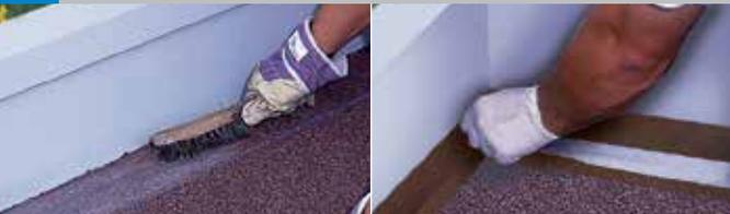
Élimination des paillettes d'ardoise à la brosse métallique. Mise en œuvre d'un renfort **Alsan® Voile Flashing** de développé 0,10 m collé à l'aide d'**Alsan® Flashing** (500 g/m<sup>2</sup>).
