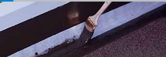
Application au rouleau d'une 1<sup>ère</sup> couche d'**Alsan® Flashing** avec un talon de 15 cm minimum et remontant sur 15 cm minimum au-dessus de la protection gravillons. Séchage de 2 à 5 heures minimum (selon conditions météorologiques).
