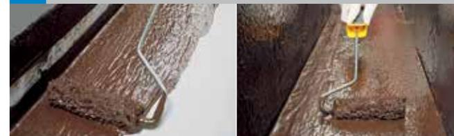
Appliquer au rouleau une première couche d'**Alsan® Flashing** sur la totalité de la surface à traiter. Renouveler l'opération une fois.
