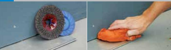
Anciens chéneaux métalliques : brosser le chéneau à l'aide d'une brosse métallique. Puis nettoyer à l'aide d'**Alsan® Diluant V** et d'un chiffon. Renforcer les soudures de raccord de tôle et les évacuations d'eaux pluviales à l'aide d'**Alsan® Voile Flashing** collé avec **Alsan® Flashing** (500 g/m<sup>2</sup>) puis en 2 couches **Alsan® Flashing** (900 g/m<sup>2</sup> + 700 g/m<sup>2</sup>) sur le développé du chéneau.
