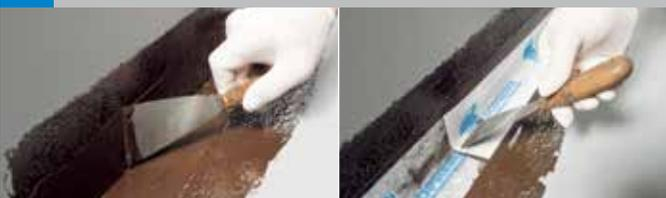
À l'aide d'un pinceau, d'un rouleau ou d'une spatule, appliquer une couche d'**Alsan® Flashing** sur la partie du chéneau destinée à recevoir un renfort **Alsan® Voile Flashing**. Positionner **Alsan® Voile Flashing** sur la résine fraîche en utilisant un pinceau ou une spatule. Veiller à la bonne adhérence de la totalité du voile au support, en particulier au niveau des recouvrements. Procéder de la même manière à la pose du voile pour les fissures éventuelles.
