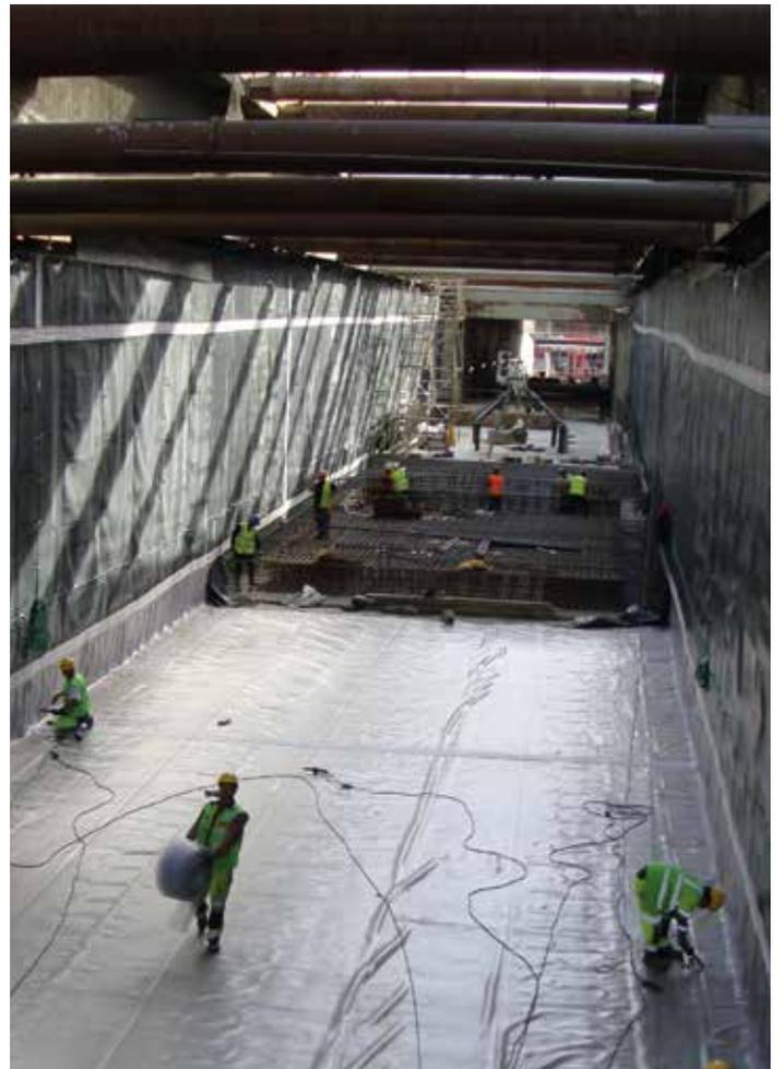
Cuvelage avec étanchéité synthétique
