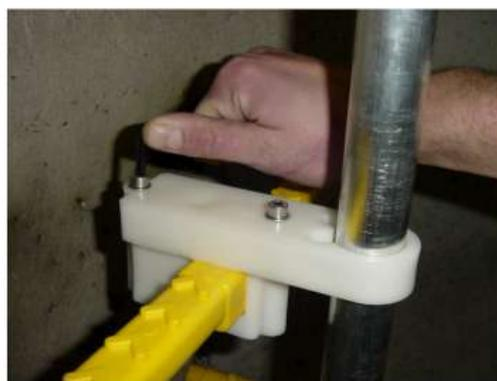
5. Une fois les deux fixations ajustées, serrer sans forcer les têtes de vis
