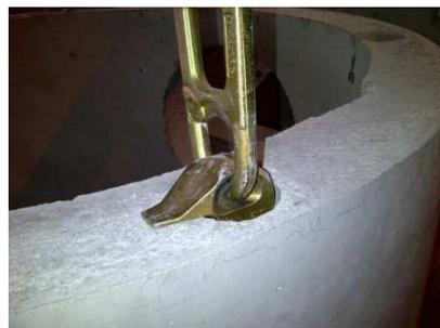
ancre insérée dans le béton
