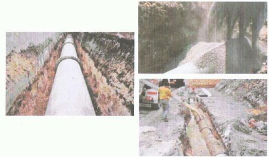
Pour toutes les canalisations, il est recommandé de réaliser une zone d'enrobage soignée.
