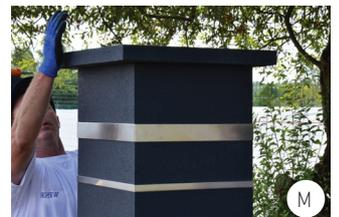
1. Une fois le dernier élément de pilier posé, remplissez-le de béton et égalisez la surface en conservant un retrait d'un demi centimètre pour le double encollage de barbotine (mélangez de l'eau et du ciment jusqu'à obtention d'une pâte) (photo K).
