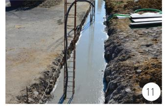
1. Remplissez d'un béton de fondation. Pour calculer le volume de béton de fondation nécessaire, il faut multiplier la longueur par la largeur par la hauteur. [9]
